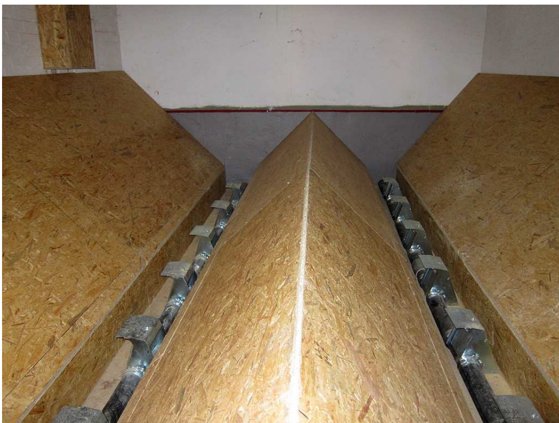
Abbildung 30 Pelletlager Wellerode (Quelle Energie 2000)
