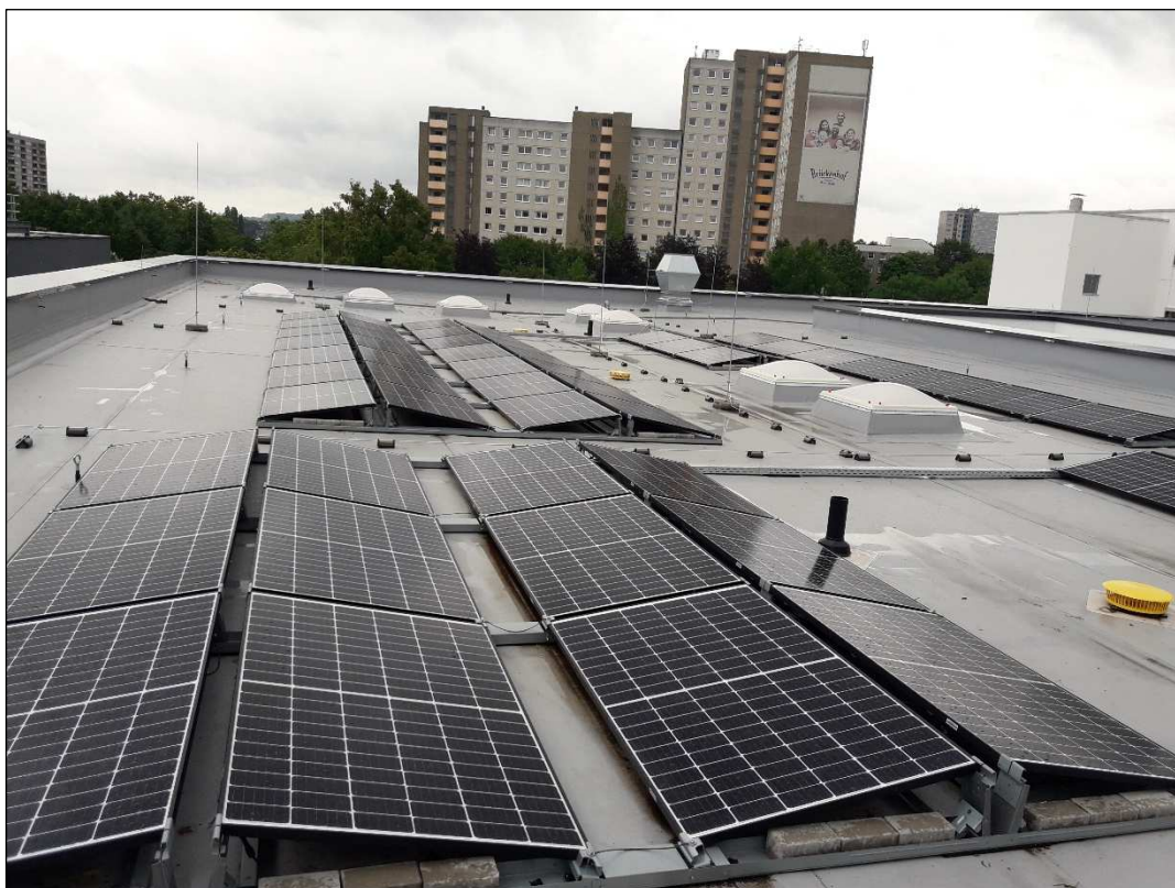
Abbildung 21 Willy-Brandt-Schule, 23,4 kW, Ost/West- Ausrichtung (Quelle: Energie 2000)
