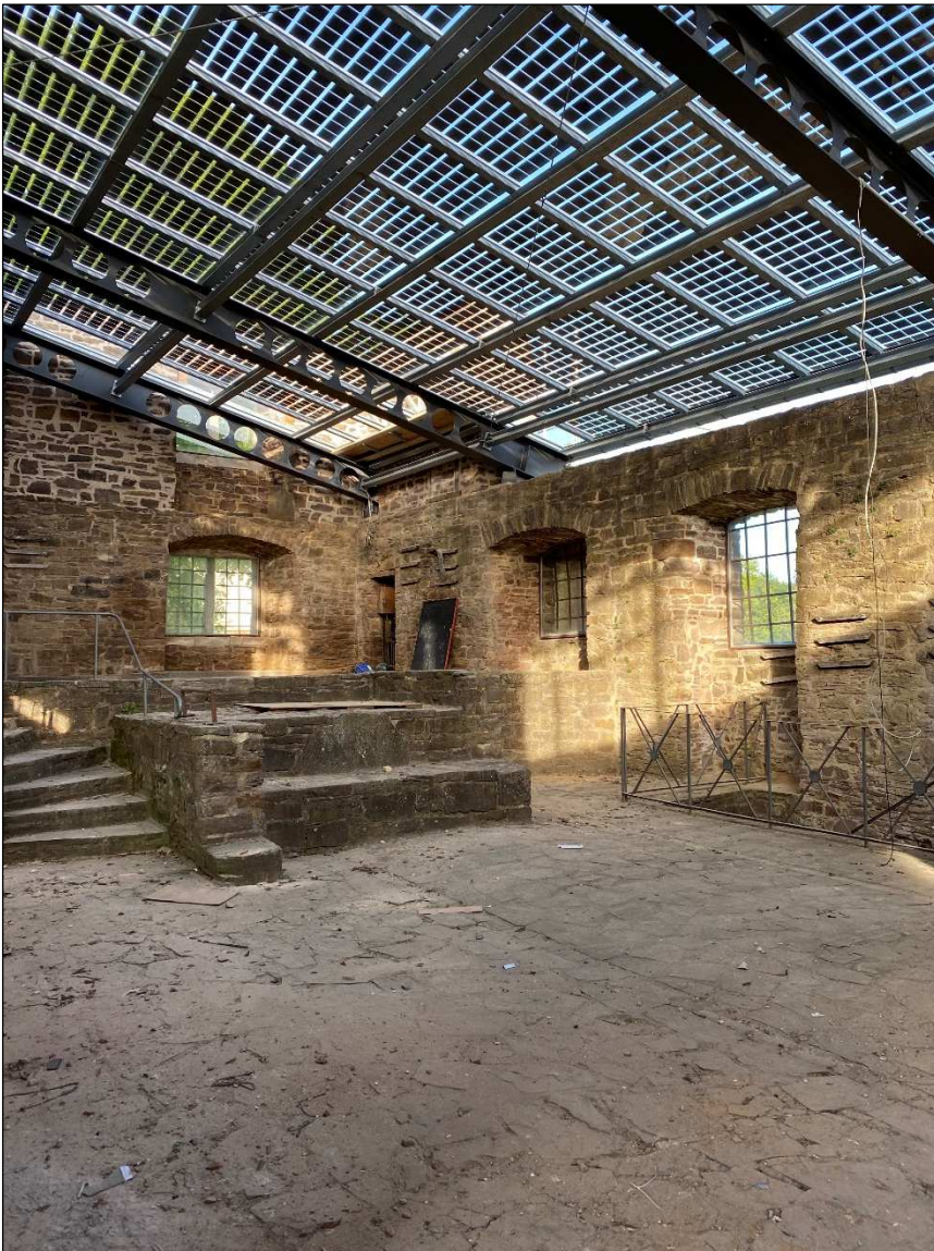
Abbildung 22 Herrenhausruine Wülmersen 27 kW (Quelle: Eigenbetrieb Jugend- und Freizeiteinrichtungen)
